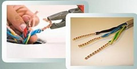
Соединение проводов клеммами
