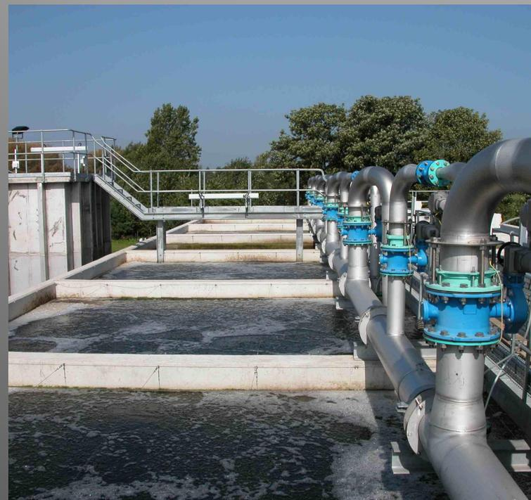
*На втором этапе очистки сточных вод полного цикла предприятий используется физико-химический метод водоподготовки, в процессе которого в воду добавляются различные реагенты. Вступая в реакцию с растворенными в сточной воде веществами, реагенты выделяют из нее примеси, которые удаляются при нейтрализации стоков.*
