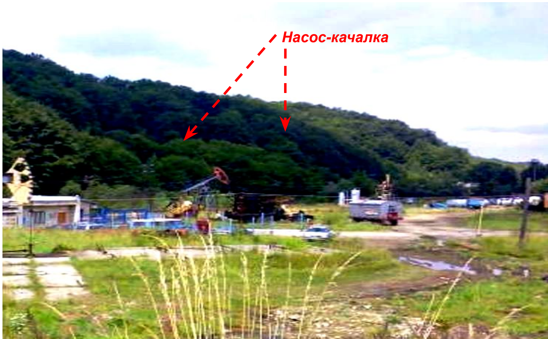
Нефтяные скважины оборудованные насосами-качалками
