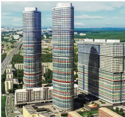
г. Москва, ЖК «Триколор» Теплосчетчики с RS 485 более 1500 шт Счетчики воды с RS 485 более 3000 шт
