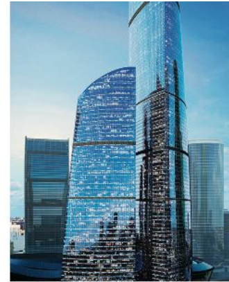
Москва-Сити, Башня Федерация. Автоматизация учета воды на базе счетчиков импульсов - регистраторов «Пульсар».
