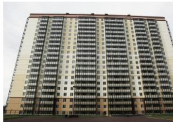
Ленинградская обл., Всеволожский район, п. Девяткино, ЖК «Мой город», номера домов с 3 по 9. Распределители тепла «Пульсар» - 5418 шт.
