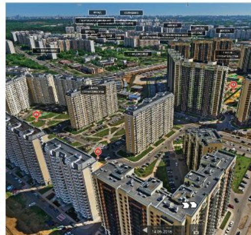
г. Москва, ЖК «Перedelкино Ближнее» Теплосчетчики более 3000 шт Счетчики воды более 6000 шт
