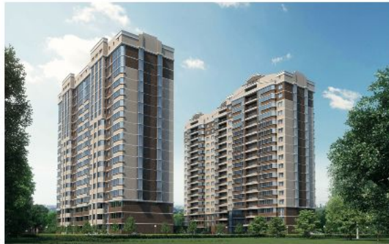
г. Краснодар, ЖК «Ежи». Квартирные теплосчетчики «Пульсар» - 500 шт.
