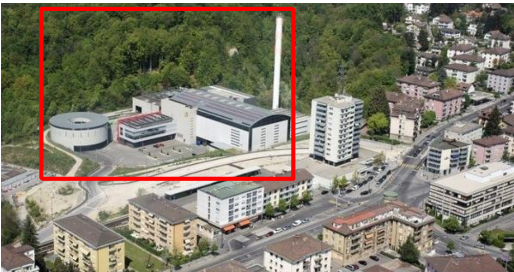
Лозанна, Швейцария, год постройки: 2006, мощность: 160 000 тонн в год
