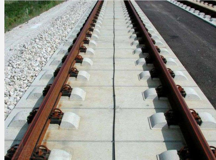
Рисунок 14 – Плиты безбалластного мостового полотна
