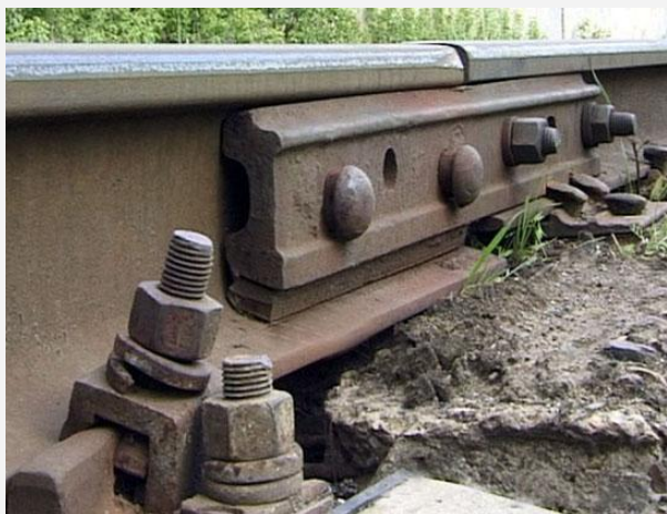
Рисунок 8 – Переходная накладка Р65 - Р75
