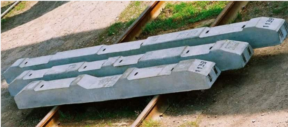
Рисунок 14 – Разновидности шпал и брусьев
