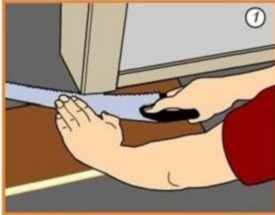
1 - Подпиливаем дверные косяки на толщину напольного покрытия
