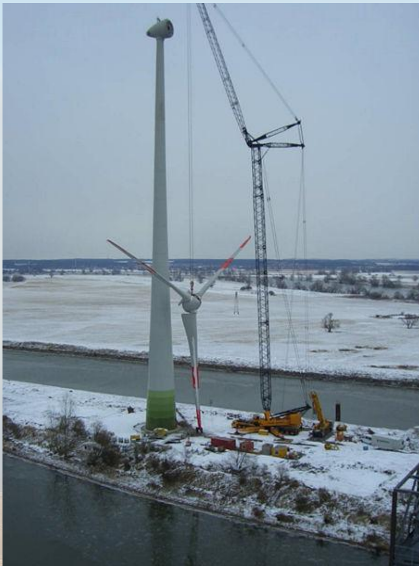
Строительство прибрежной электростанции в Германии.
