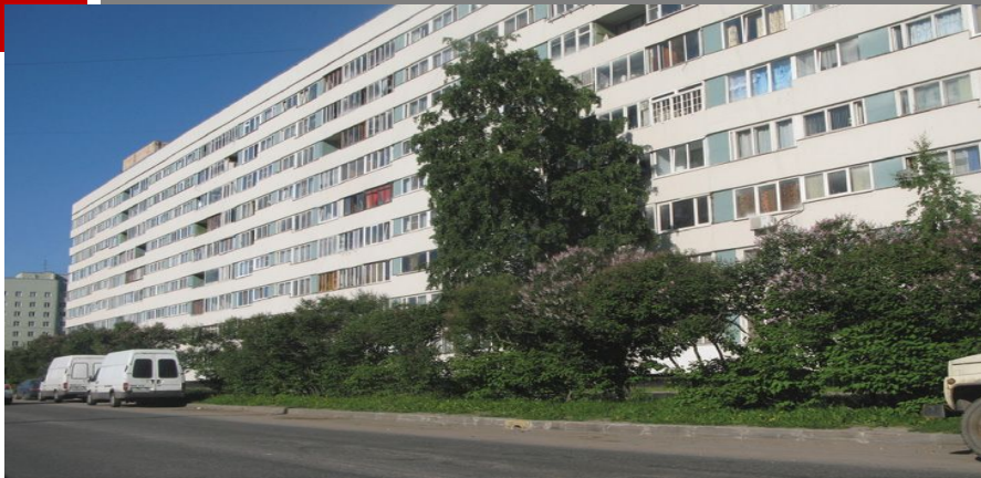
1970-й. ДСК-3, D600 Санкт-Петербург, Ушинского, 8 («корабль»). Заводская отделка — цементная краска без гидрофобизации. Фасад отреставрирован в 2010 м: тонкослойная штукатурка по сетке
