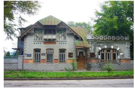
Дом архитектора Ф. О. Ливчака 1914 г.
