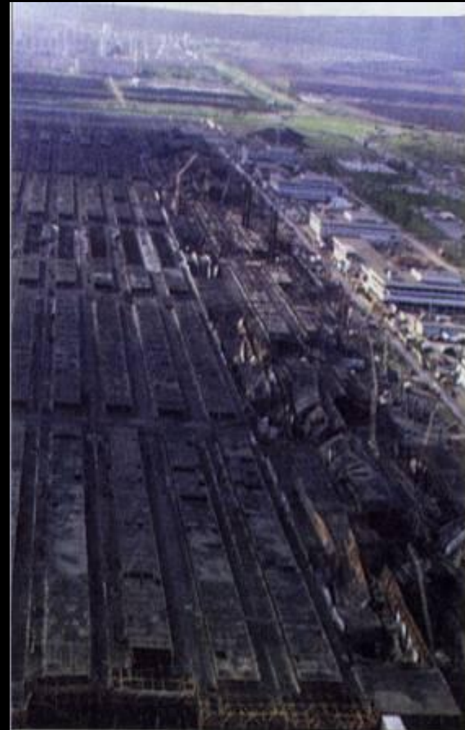
Последствия пожара на заводе двигателей АО «КамАЗ»
