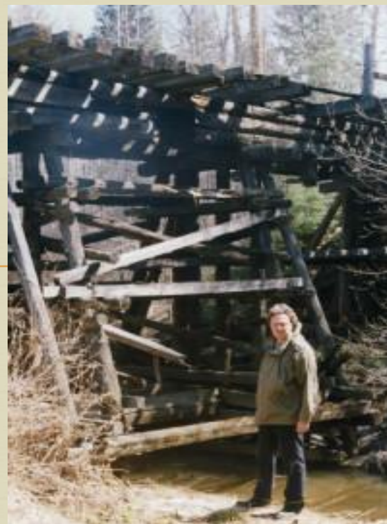
Мост через Илевку
