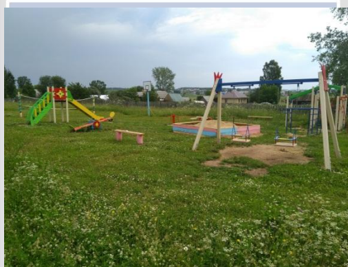
Строительство детской спортивной площадки (ТОС «Савинский»)
