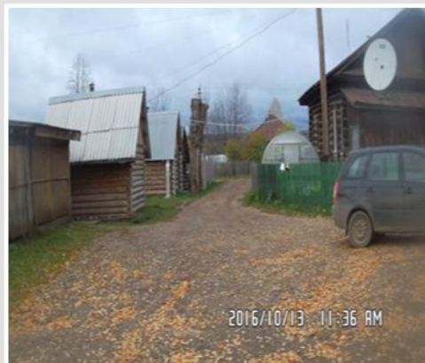
Ремонт и прокладка дорожно-тропиночной сети (ТОС «Перекресток»)
