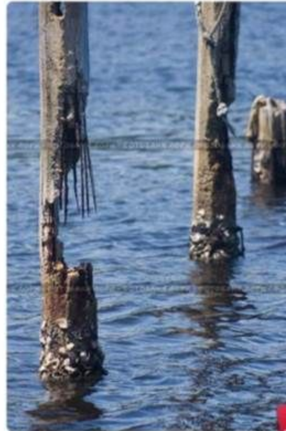
Старые бетонные столбы, торчащие на воде. Коррозия металла и разрушение бетона. © Юрия Коваленко / Фотобанк Лори
