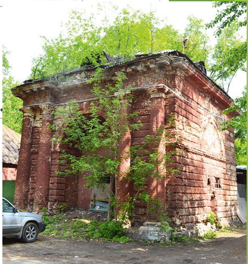
Первый ярус бывшей въездной башни Хорошевского конного завода (XVIII век)
