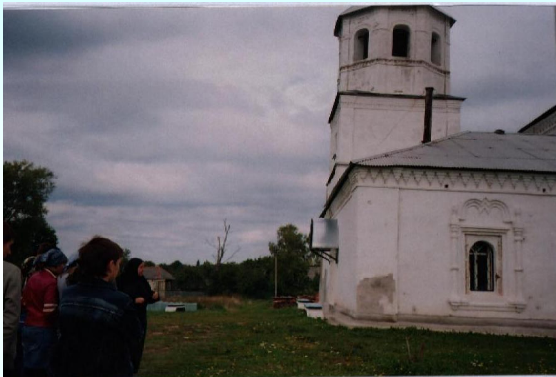
Церковь Воскресения Христова, идут строительные работы
