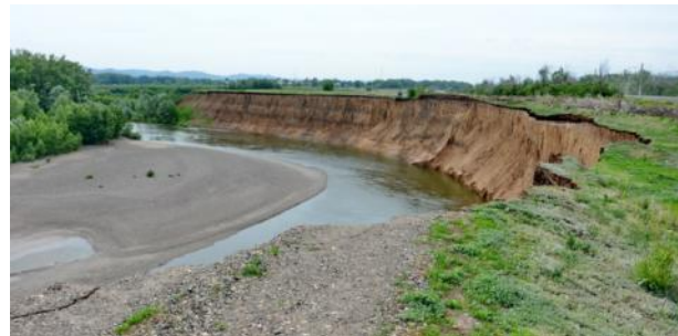
Угроза разрушения железнодорожного полотна излучиной р.Сакмара у с. Жёлтое (2017 год)
