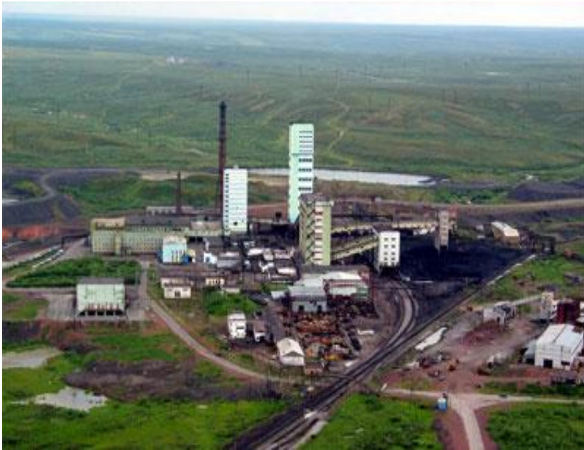
Шахты Печорского угольного бассейна
