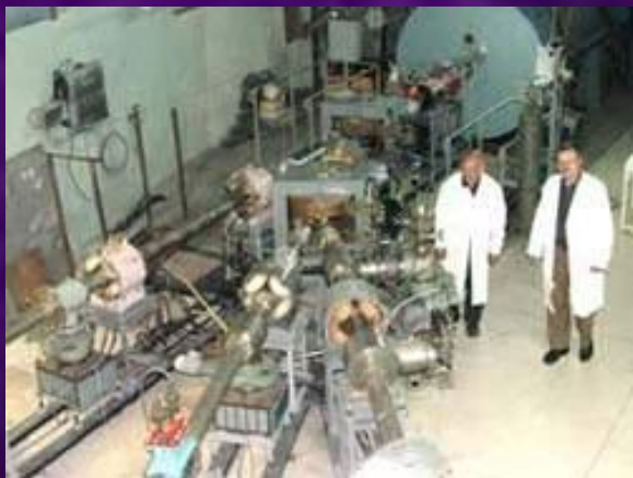
Смонтированное оборудование канала перевода пучка в зале И-100
