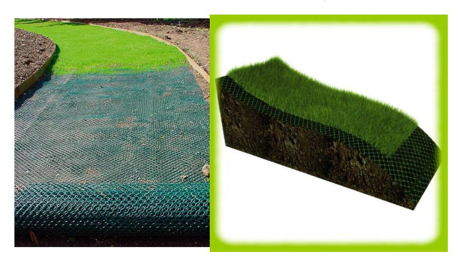
3. Применение ENKAMAT. ENKAMAT - богатый пустотами полиамидный структурный материал, который раскатывается на выровненную поверхность плодородного фунта и закрепляется шпильками. После этого производится посев семян газонных трав с последующим мульчированием, ENKAMAT, удерживая мелкие частицы почвы и семена, создает тем самым условия для роста растений и обеспечивает защиту от эрозии. Маты служат долгосрочным армированием корневой зоны формирующейся дернины.
