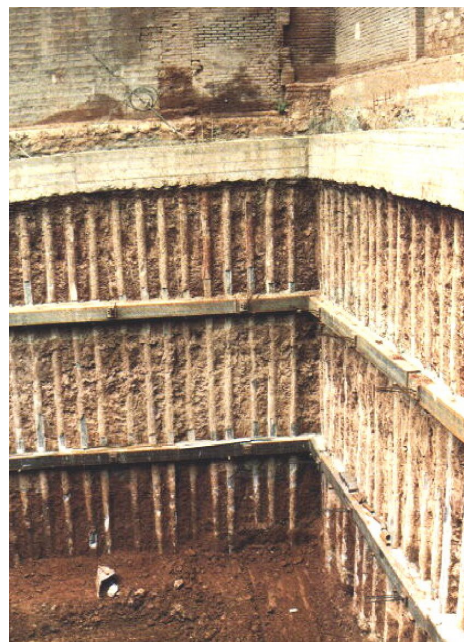
Устройство ограждений из буровых свай
