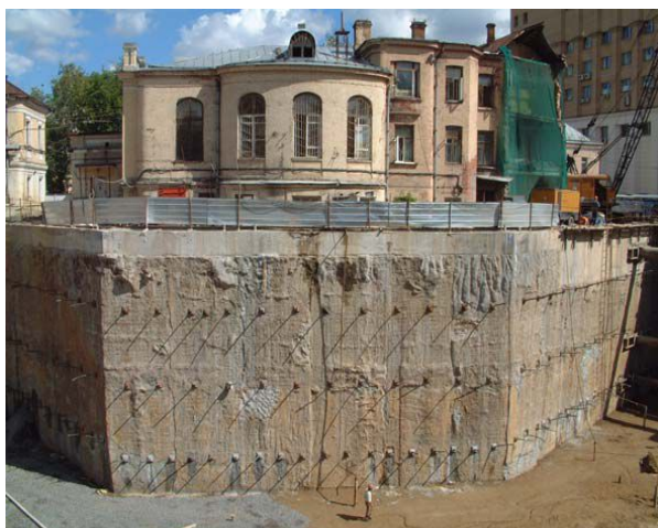
Применение способа «стена в грунте»
