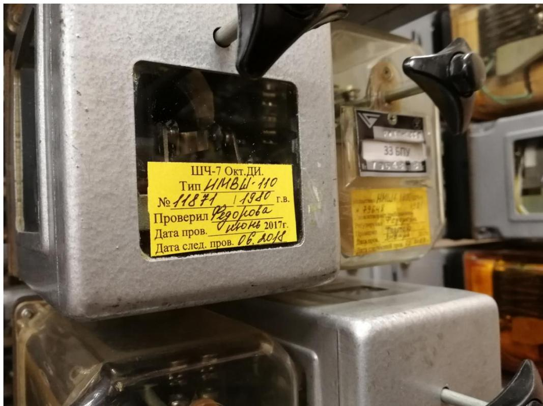
Реле ИМВШ-110 или ИВГ с одним контактным тройником, через контакты которого включается повторитель.
