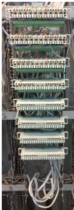
Рисунок 7.3 Фасад размещения плинтов в монтажных хомутах
