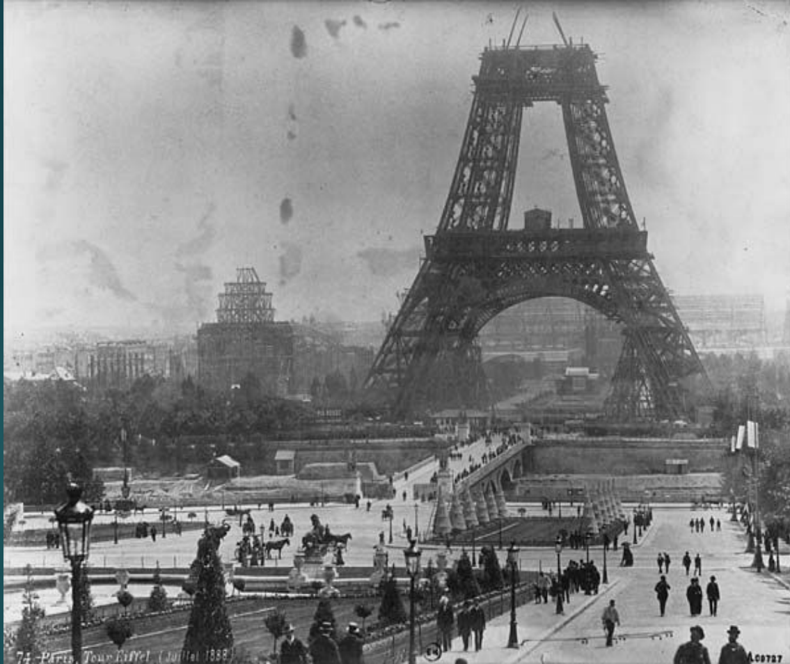
Будівництво вежі, липень 1888
