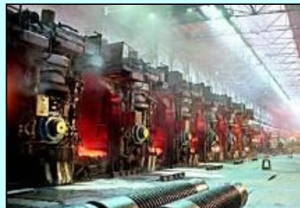
Непрерывный шестиклетьевого стан 1700 состоит из 6-ти четырехвалковых клеток КВАРТО. Прокатка полос от 0,8-6 мм.
