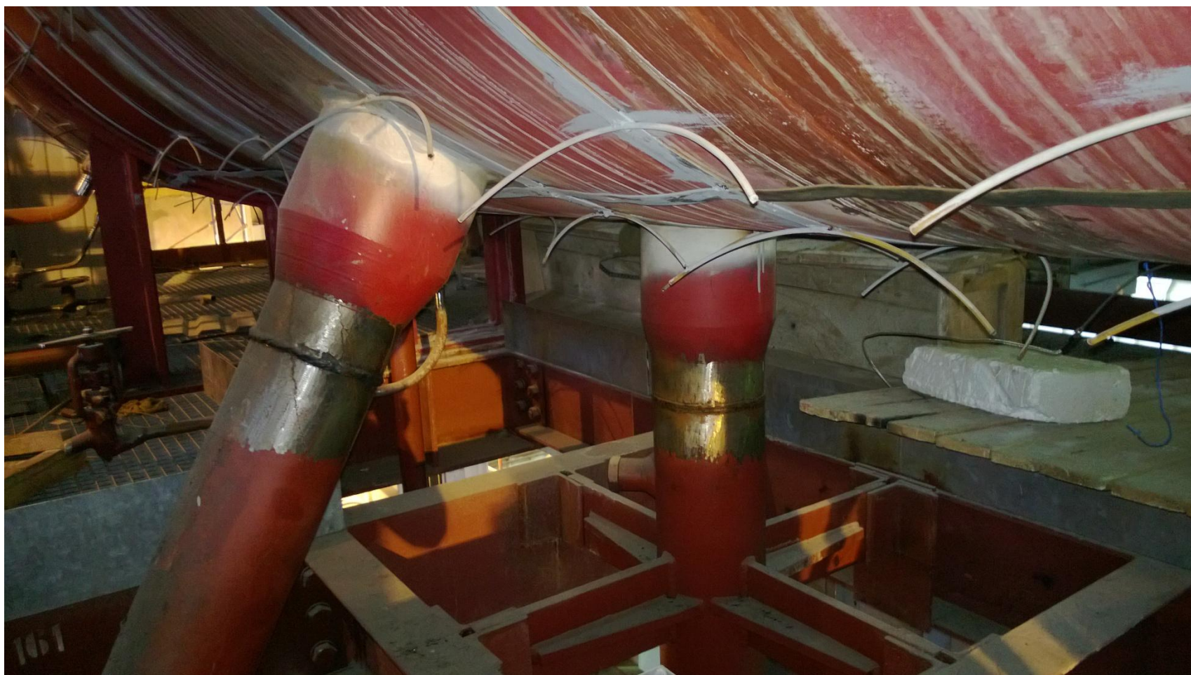
Рис. 15.1. Опускные трубы барабана
