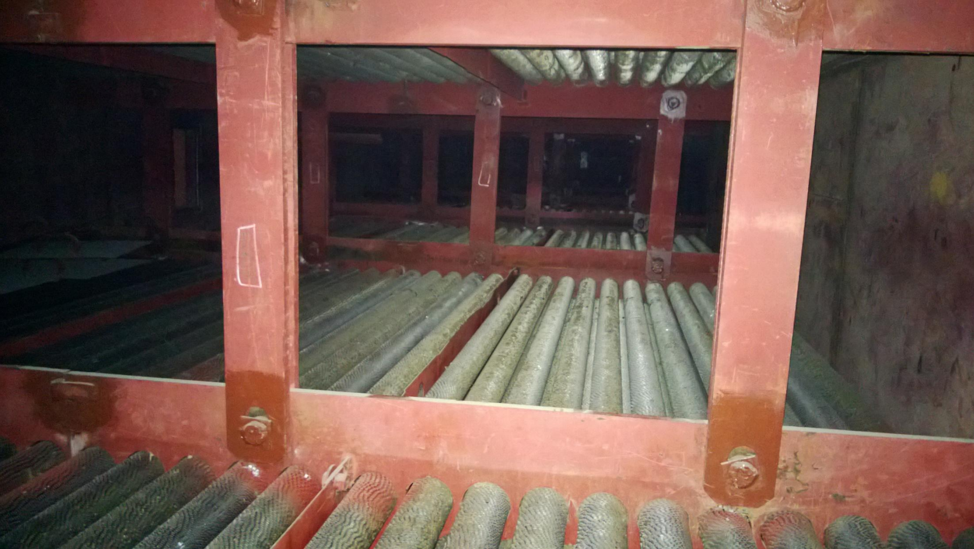
Рис. 12.2. Поверхности нагрева
