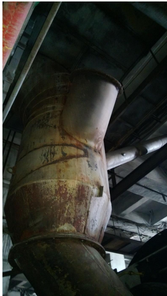
Подвод угля с взрывным клапаном и возврат пыли в ШБМ
