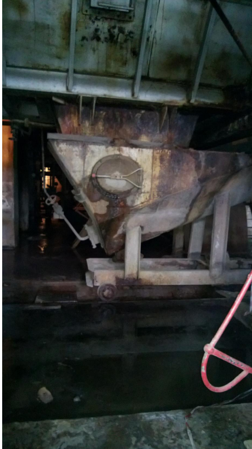
Рис. 14.1. Система шлакоудаления
