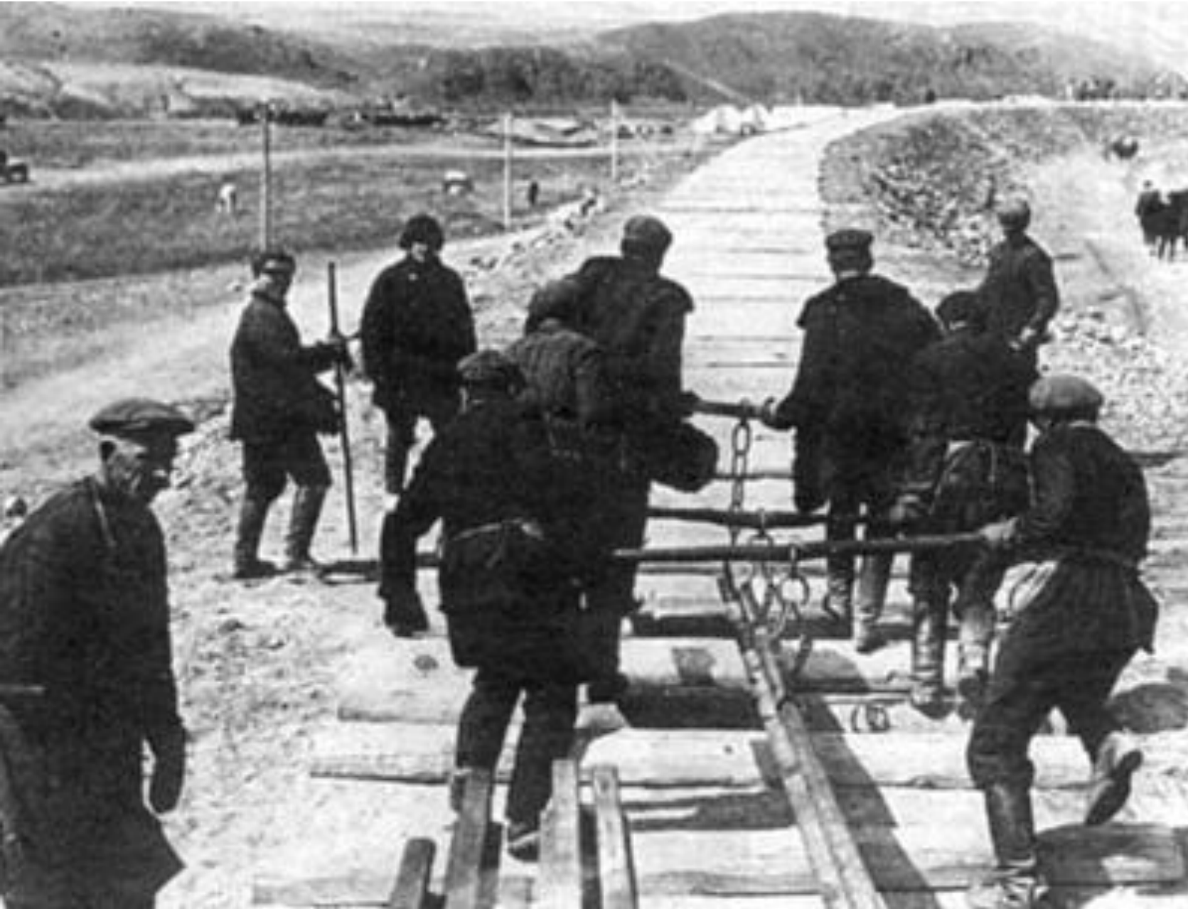
Строительство железной дороги
