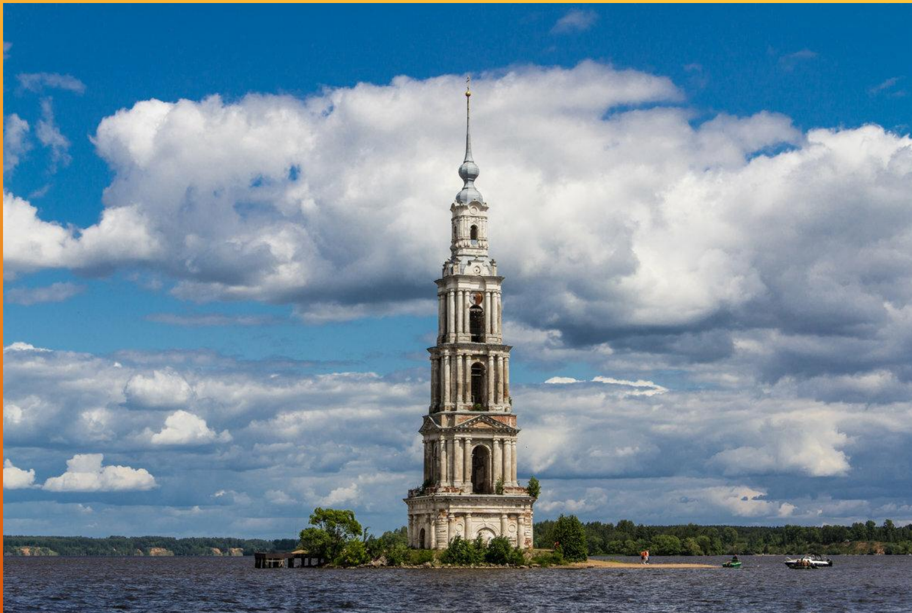
Колокольня Никольского собора. Г. Калязин
