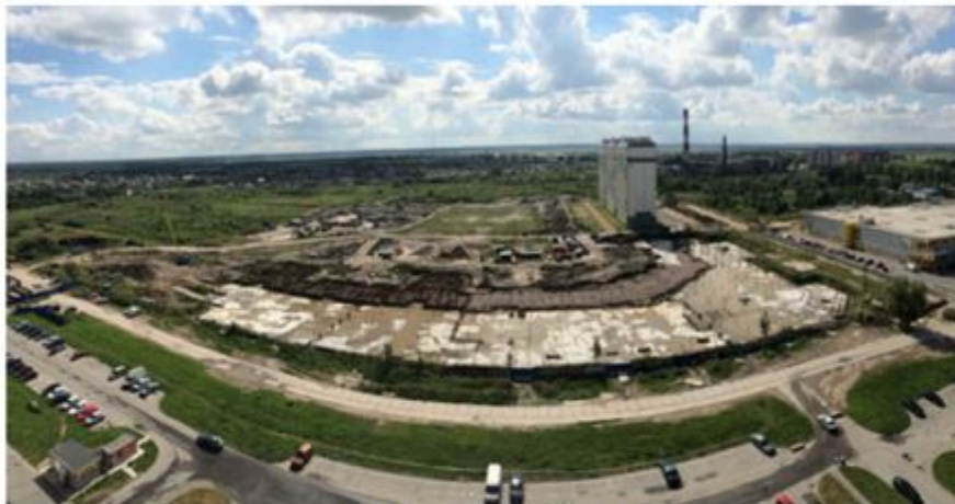
Вид на строительную площадку
