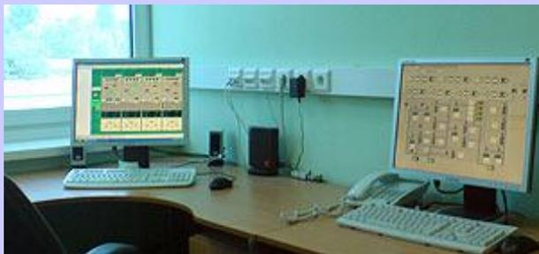
В качестве инструмента для разработки АСУ переработки овощей и фруктов была выбрана популярная SCADA-система TRACE MODE. Первое внедрение SCADA TRACE MODE на перерабатывающем комбинате Ольвита – автоматизированная система управления
