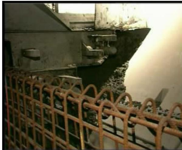
Бетонирование по арматурному каркасу
