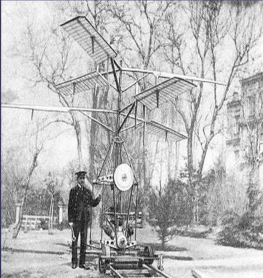
В 1908—1911 гг. построил свои первые два простейших вертолётa соосной схемы без автомата перекоса. Грузоподъёмность построенного в сентябре 1909 года аппарата достигала 9 пудов. Он был представлен на двухдневной воздухоплавательной выставке в Киеве в ноябре того же года. Ни один из построенных вертолётов не смог взлететь с пилотом, и Сикорский переключился на постройку самолётов.
