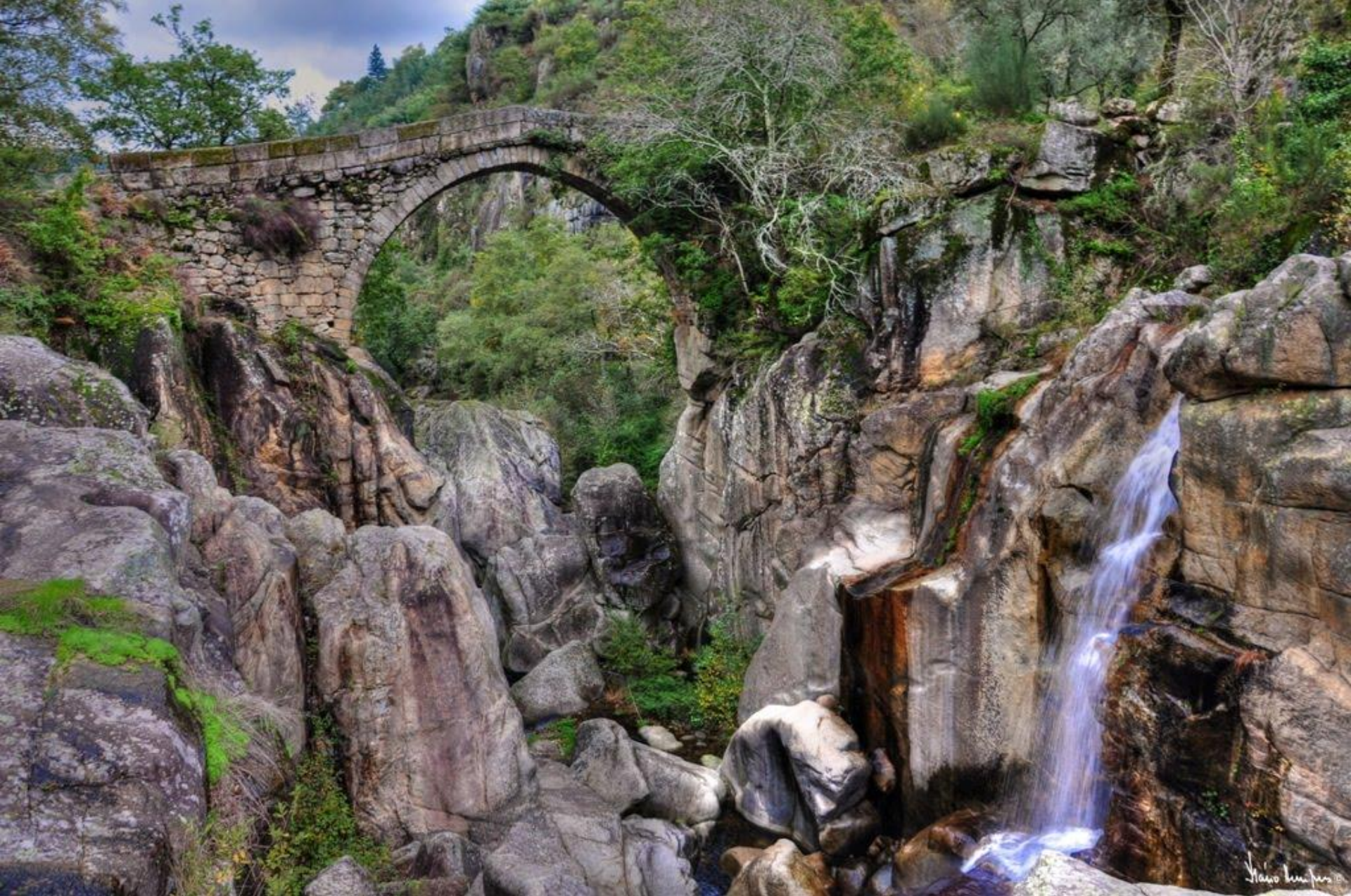
Ponte da Misarela (Montalegre). Fica por cima do rio Rabagão e conta a lenda que foi erguida pelo diabo. É uma das Pontes do Diabo existentes do mundo, por ligar duas margens muito íngremes.
