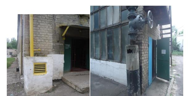
□На высоте 1,5-2 м от основания установлено отключающее устройство - задвижка.
