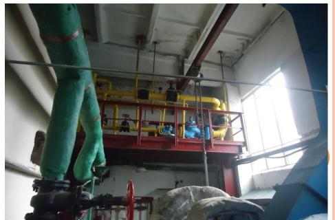
Для полученияя необходимого давления в котельной установленно ГРУ, в котором давление газа снижается и поддерживается в заданных пределах независимо от расхода и колебания в сети. ГРУ предназанчен для снижения давления газа, поддержания его на заданном режиме, независимо от расхода газа, а также для автоматического отключения подачи газа потребителю в случае повышения или понижения давления газа от заданых режимов
