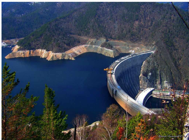
Саяно-Шушенская ГЭС – Вторая жизнь
