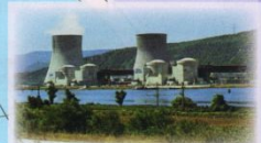
Атомная электростанция во Франции
