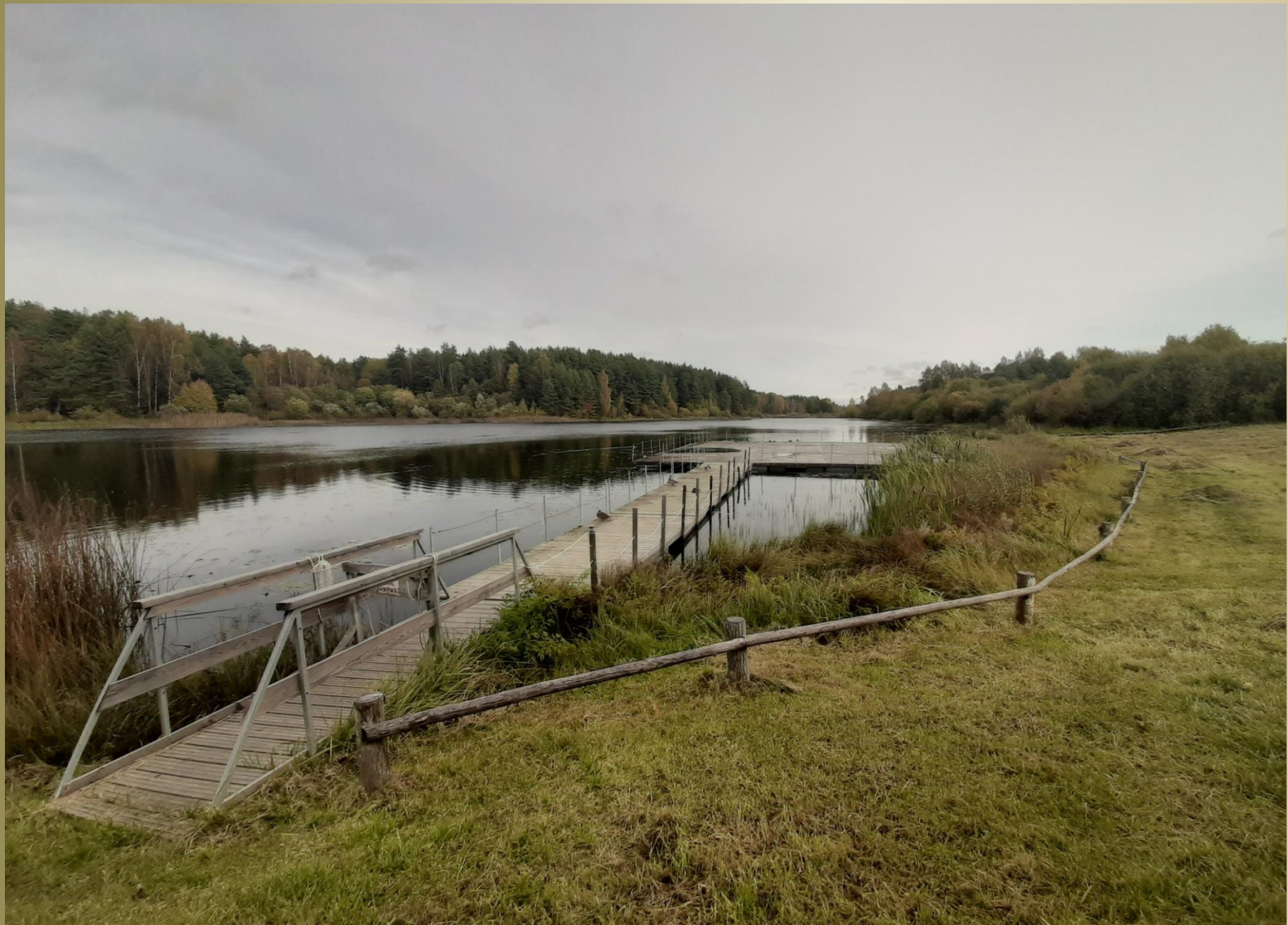
Мельничная плотина на берегу Бугровского пруда.
