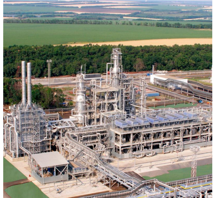
Общий вид установки первичной переработки нефти
