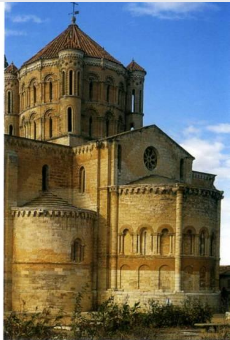
8. Собор в Торо. Испания, 1160. Типичная особенность архитектуры Пиренейского полуострова – крупная башня средокрестия с равномерным ритмом арок и четырьмя башенками по углам.
