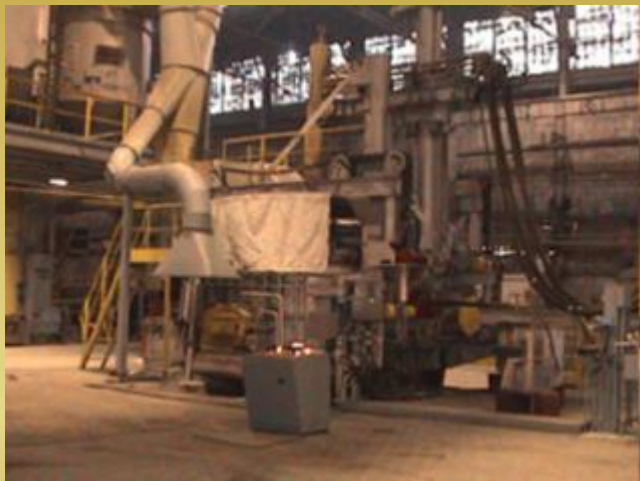
Заводы передельной металлургии
