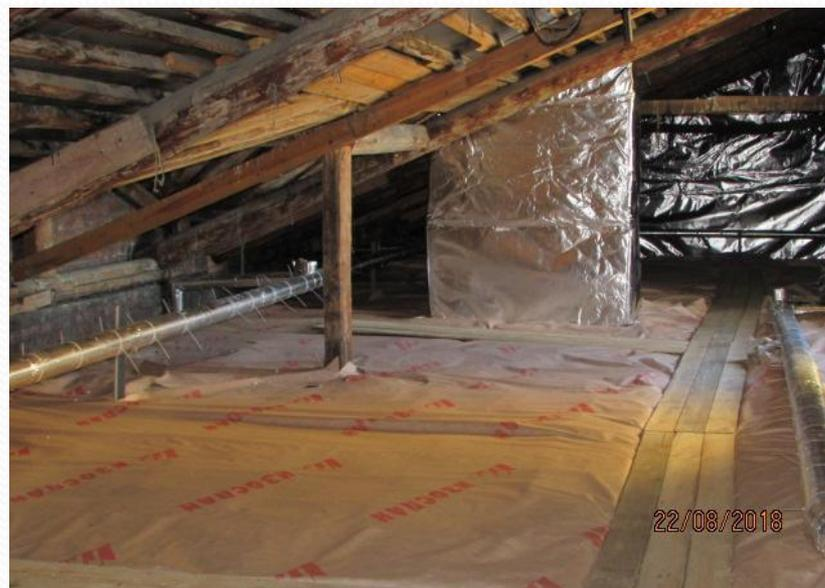
**Проведены работы по восстановлению изоляции вентиляционных каналов и входов в чердачные помещения
