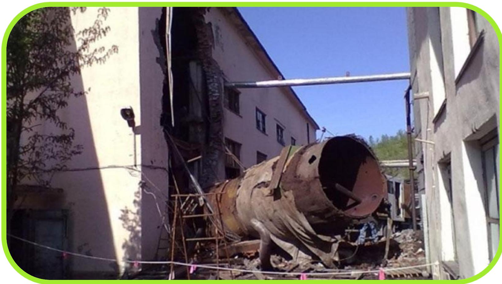
**Разрушение обмуровки котлоагрегата и строительных конструкций котельной**
