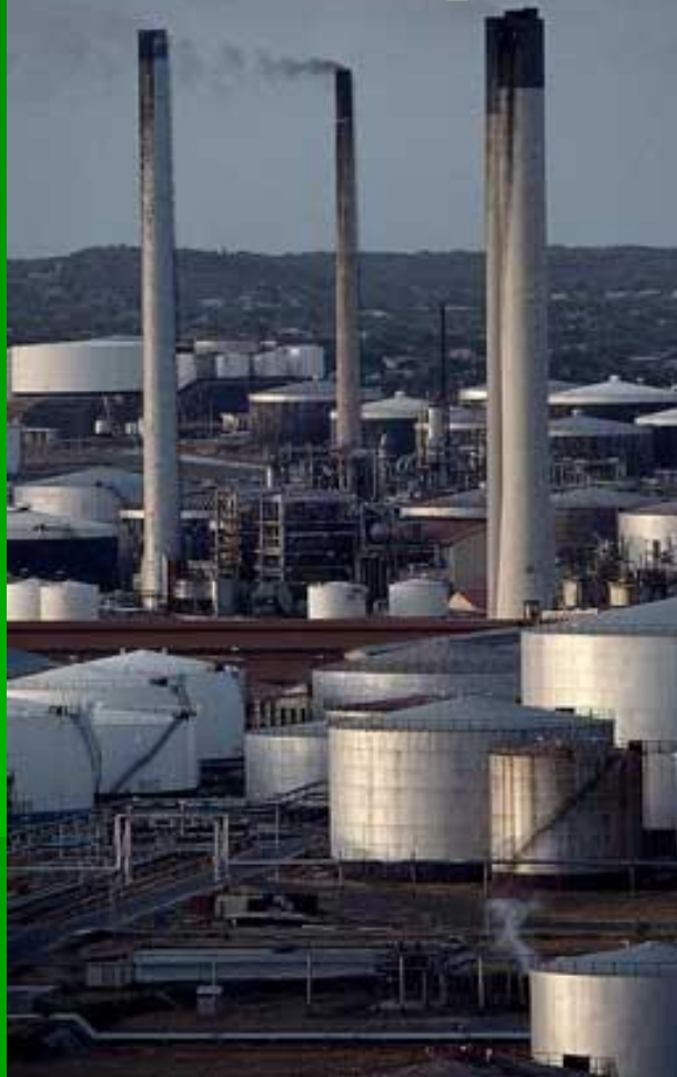
Завод по переработке нефти.
