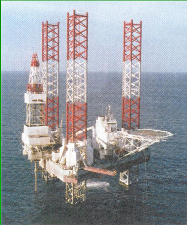
Плавучая бурильная установка на шельфе Охотского моря
