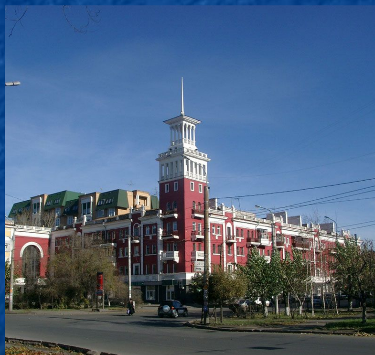
Реконструкция жилого дома в центре г. Красноярск по ул. Маркса (1991 г.)
