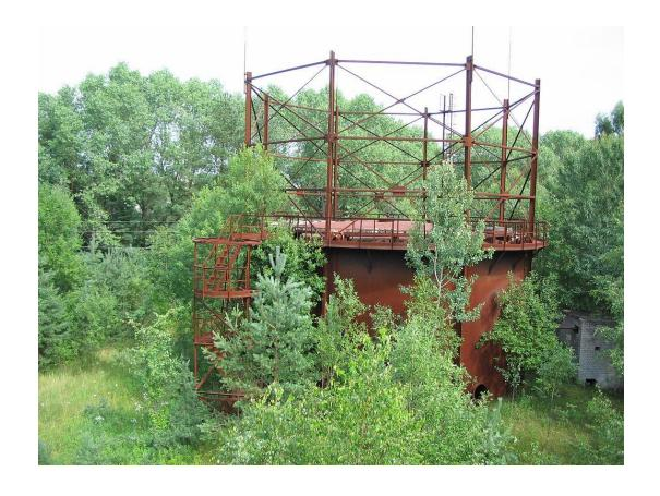
• **Метантенк** (от англ. *methane* — метан и англ. *tank* — резервуар) — устройство для анаэробного брожения жидких органических отходов с получением метана.
