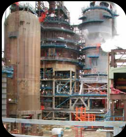
Реакторный блок каталитического крекинга по технологии ExxonMobil. В правой части - реактор, слева от него - регенератор.
