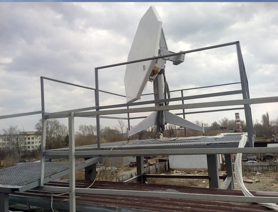
АНТЕННЫЙ ПОСТ АНТЕННАЯ КОЛОНКА ЗЕРКАЛО (ФАР) ВОЗМОЖНА УСТАНОВКА БЕЗ РПУ
