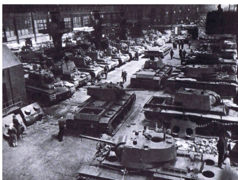
Киров зауытының цехында KV танкілерді құрастыру
