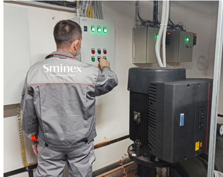
Настройка системы вентиляции
