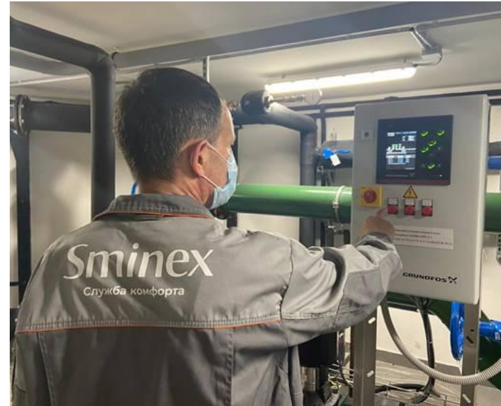
Контрольный осмотр системы горячего и холодного водоснабжения
