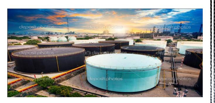
РЕЗЕРВУАРНЫЙ ПАРК — комплекс взаимосвязанных отдельных или групп резервуаров для хранения или накоплені жидких продуктов (нефти, нефтепродукто жидких углеводородов, химических продуктов, воды и др.); оборудуется
