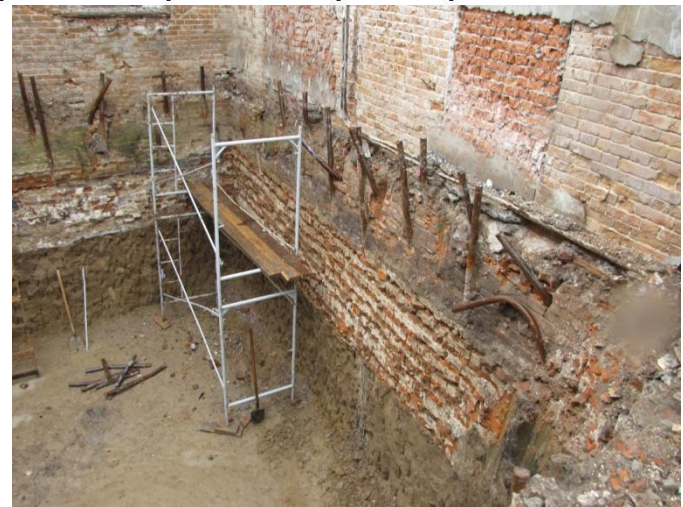
Рис. 19, 20 - Усиление фундаментов, разработка грунта
