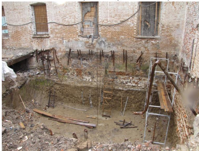
Рис. 19, 20 - Усиление фундаментов, разработка грунта
