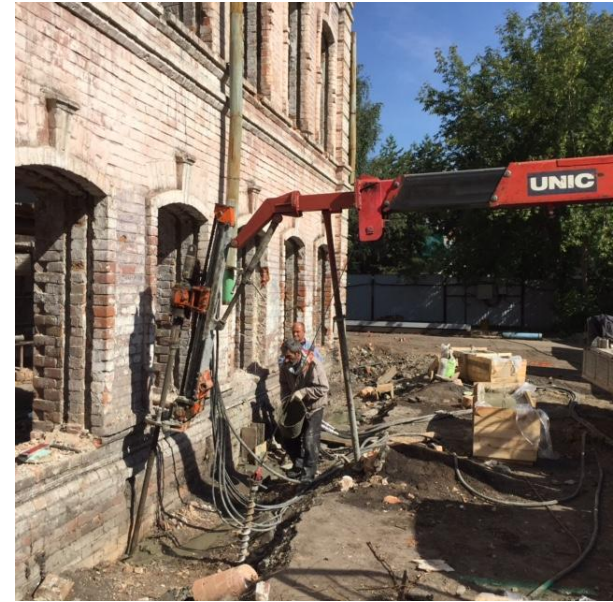
Рис. 21 - Процесс усиления фундаментов инъекционными сваями
