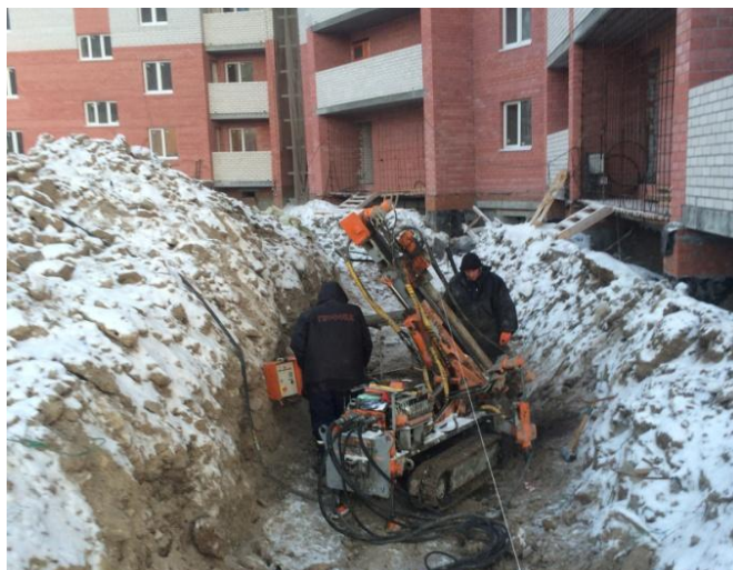
Рис. 44 - Выполнение работ по закреплению основания
