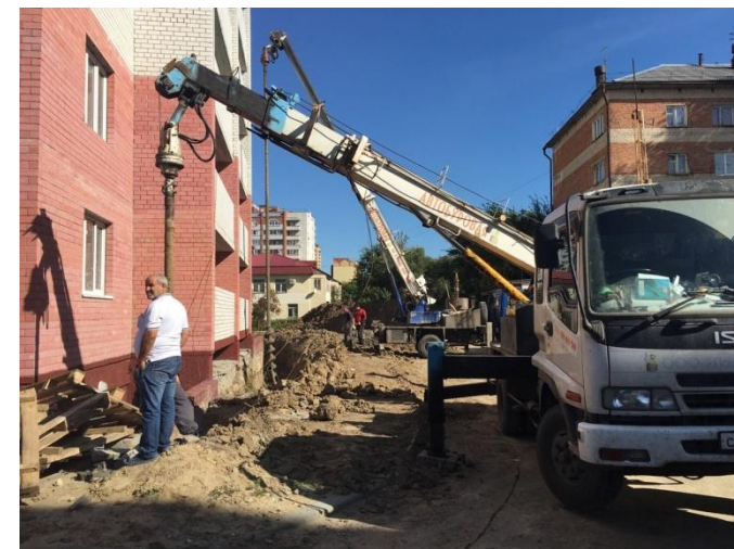
Рис. 45- Выбуривание вертикальных скважин
