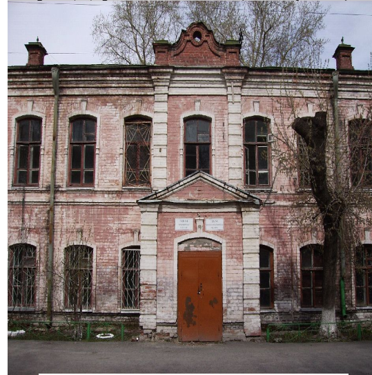
Текутьевская больница, г. Тюмень, ул. Даудельная 1а (литера А)
